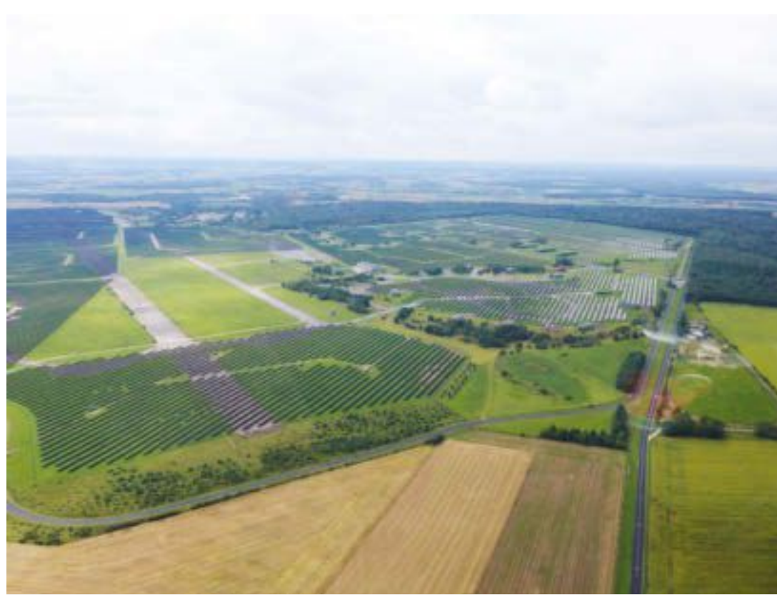
Der beeindruckende «Toul-Rosières Solar Park» befindet sich auf dem Gelände eines ehemaligen Militärflugplatzes zwischen den Gemeinden Toul und Rosières-en-Haye. L'impressionnant parc solaire de Toul-Rosières se trouve sur le terrain d'un ancien aérodrome militaire, entre le communes de Toul et de Rosières-en-Haye.
